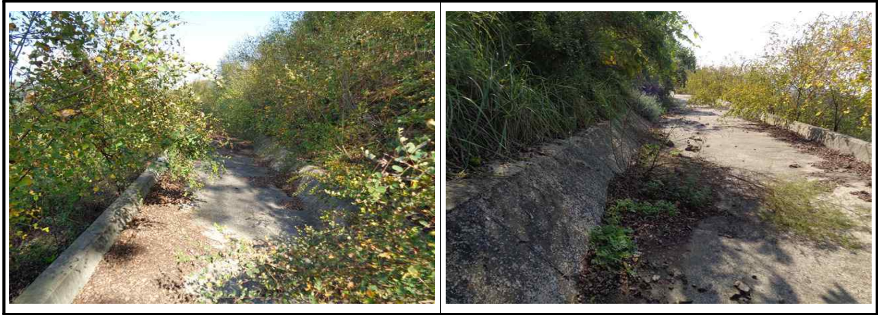
【그림 2.3.3】 배수시설 전경
